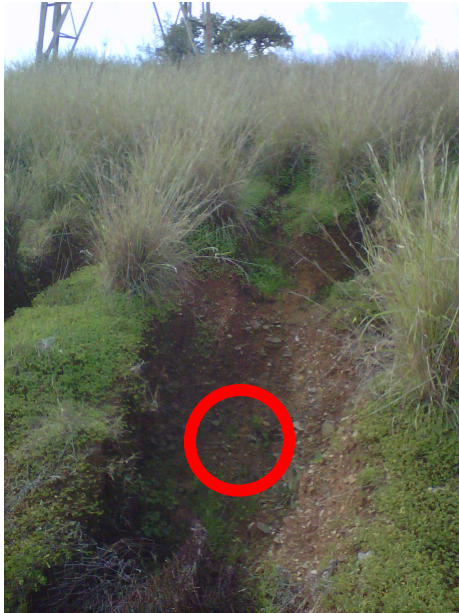
Foto 4 y 5. Detalle de suelo de recubrimiento aluvial afectado por erosión hídrica debido a una fuga importante de la conducción existente al norte de la parcela.
