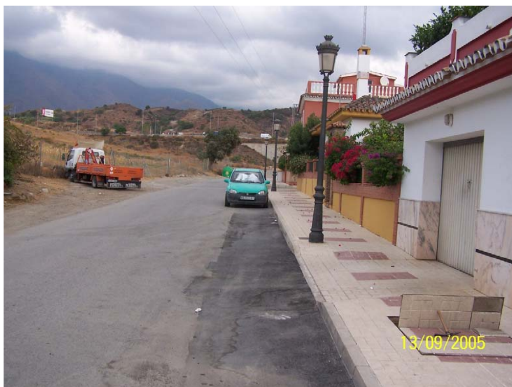
Aceras de reciente ejecución
