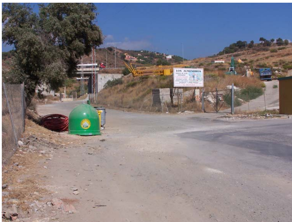
Final Calle Félix Troyano junto a centro de transformación, intersección con Calle Juan Benítez. Al fondo trampa de acarreos del embovedado del Arroyo Juan Benítez
