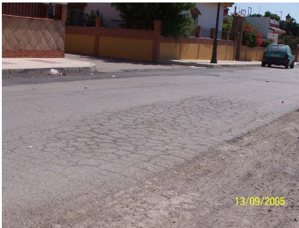
Blandones en la calzada en intersección Félix Troyano-Francisca Ortiz
