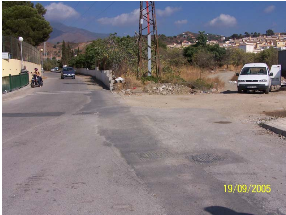
Estrechamiento de la calzada
